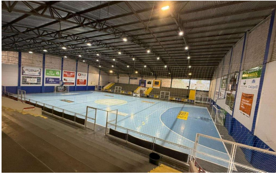
Fotos 03– Quadra Coberta Ginásio Henrique Holetz
